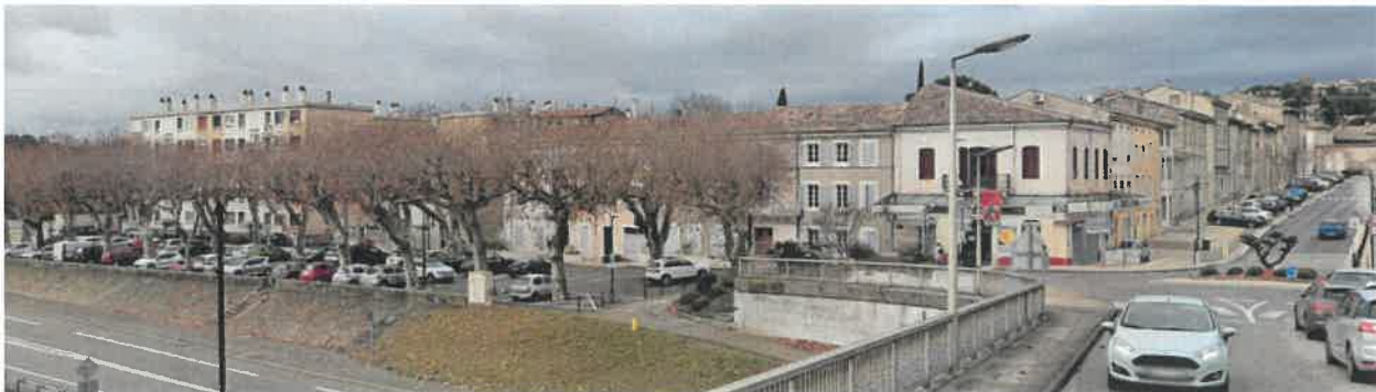
Vue sur la copropriété depuis l'entrée de ville ouest
