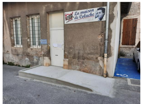
Rampe PMR restos du cœur
