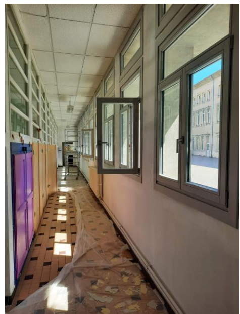
Couloir RDC école R. Cassin
