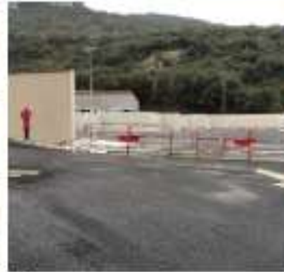
Construction déchetterie Viviers → 725 048 €
